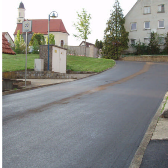
Die Sanierung der Ulrichstraße konnte ebenfalls abgeschlossen werden.
